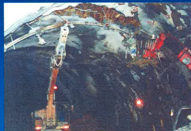
REPOSICIÓN DE HORMIGÓN PROYECTADO Y BULONADO
