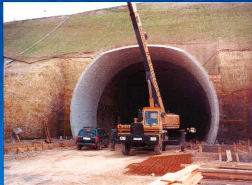
BOCA NORTE FALSO TÚNEL
