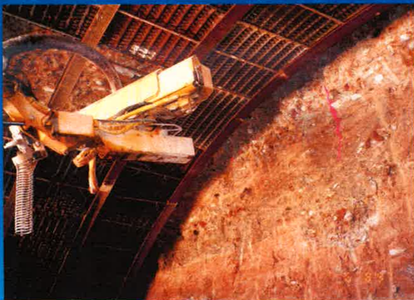
FRENTE DE EXCAVACIÓN BOCA NORTE
