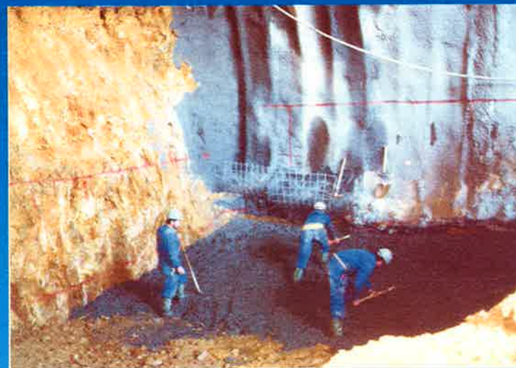
FRENTE DE DESTROZA (CALZADA DERECHA)
