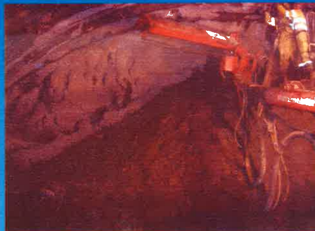
TRABAJOS DE INYECCIÓN EN CAMPANA
