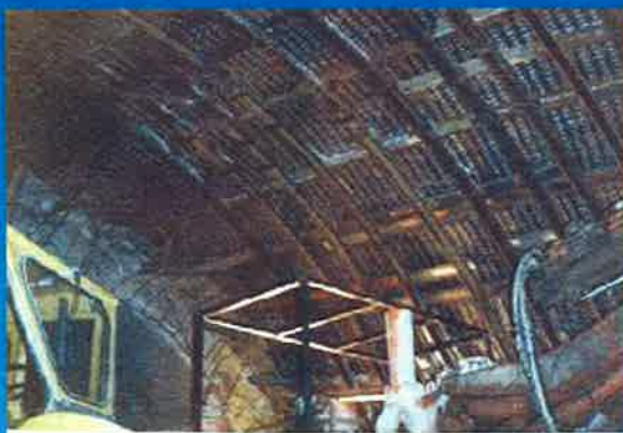
ENTRONQUE FALSO TÚNEL-SOSTENIMIENTO
