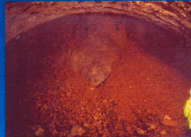
VACIADO DE CAMPANA (ZONA EMPIQUETADA)
