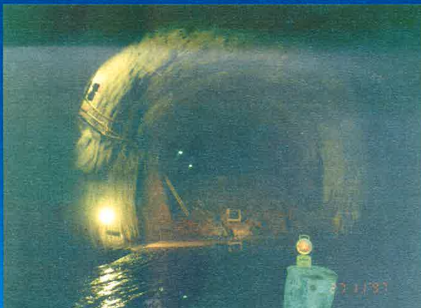
ASPECTO DEL FRENTE DE DESTROZA
