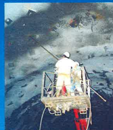
REPOSICIÓN DE HORMIGÓN PROYECTADO Y BULONADO
